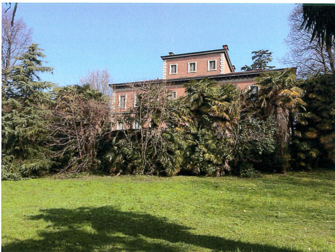
Fig. 8: Vegetazione spontanea radicata al di sotto della balconata e all'interno del muro di sostegno della stessa
