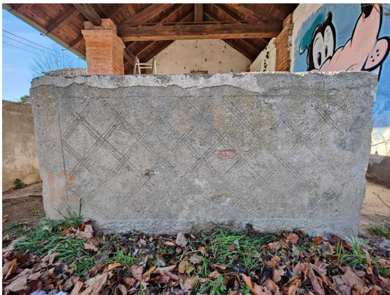
Dettaglio del muro di testa con intonaco decorato a graffito
