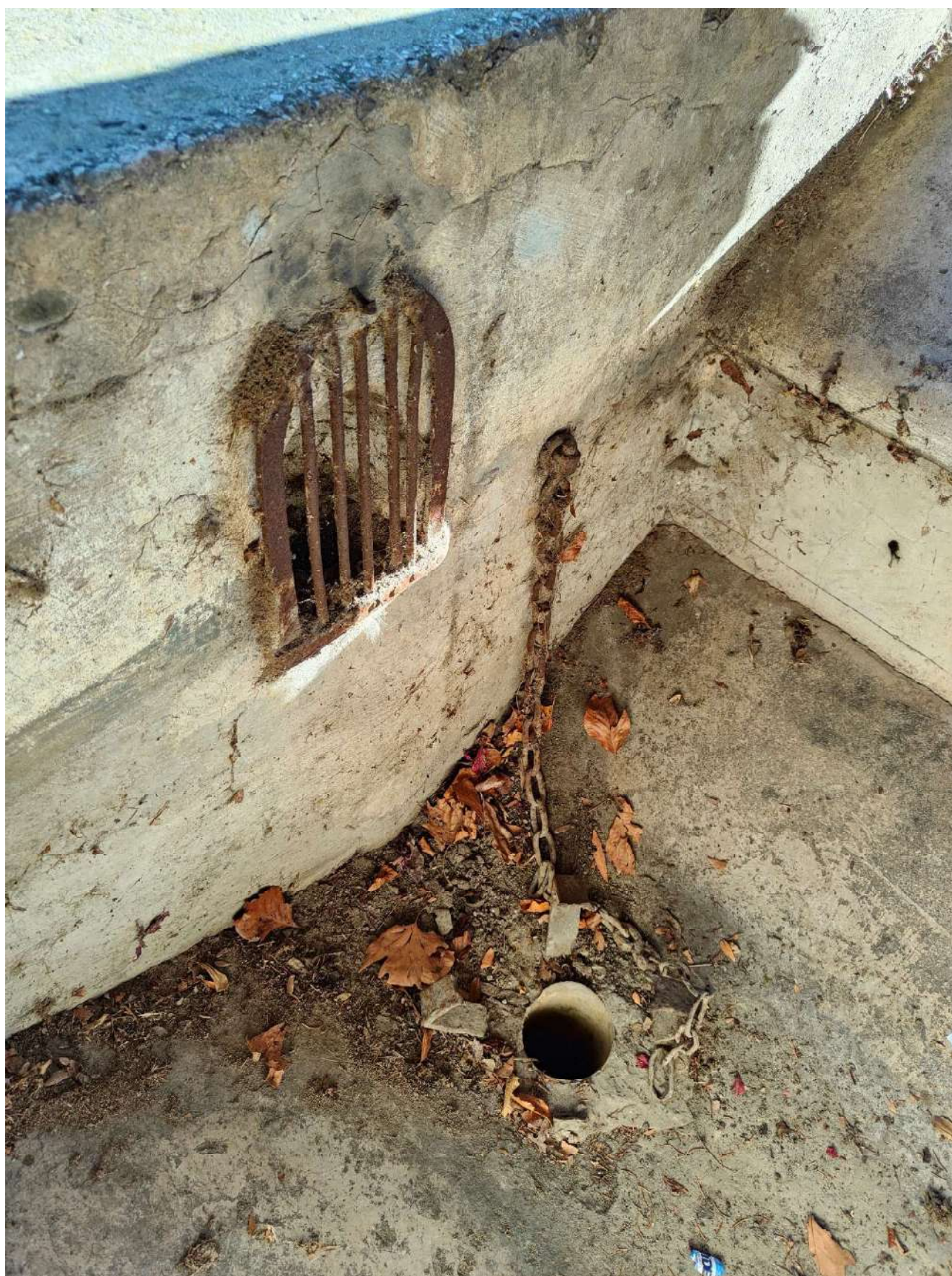
Dettaglio del sistema di scarico
