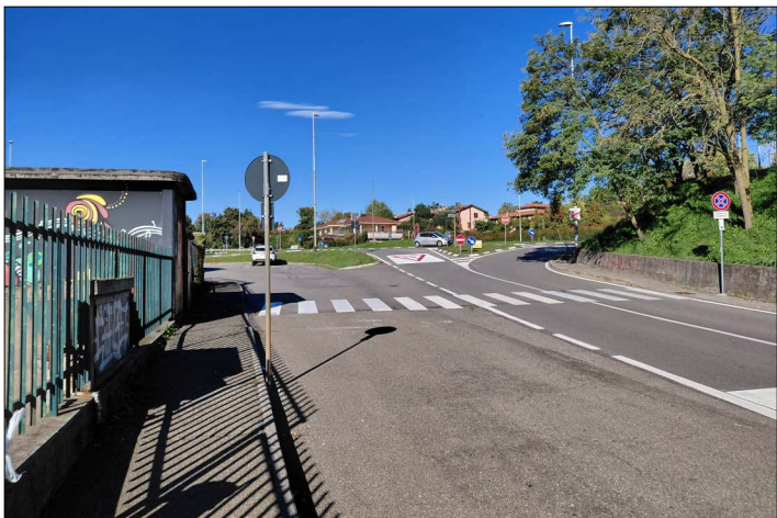
FOTO 5: attraversamento pedonale su via dei Ludovichi
