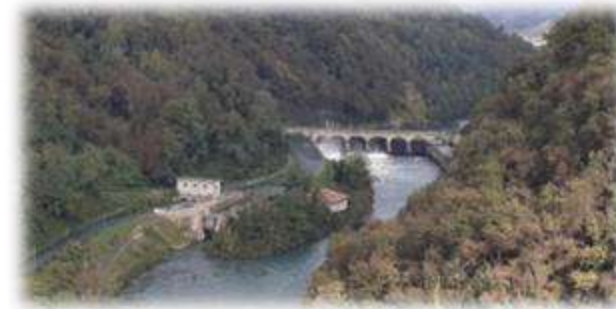
Diga di Robbiate e Centrale idroelettrica "Guido Semenza" costruita tra il 1917 e il 1920
