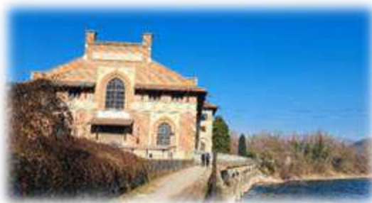
Centrale idroelettrica Carlo Esterle esempio significativo di archeologia industriale monumentale
